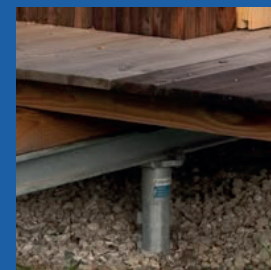
Sikring m. marksten
