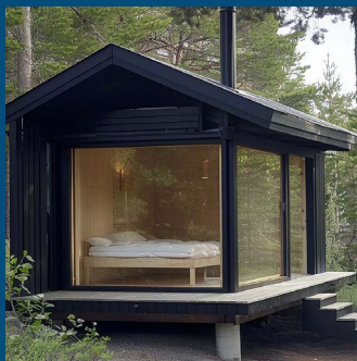
Bebyggelse og terrassedæk på brøndfundament i beton
