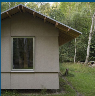
Bebyggelse på skruefundament
