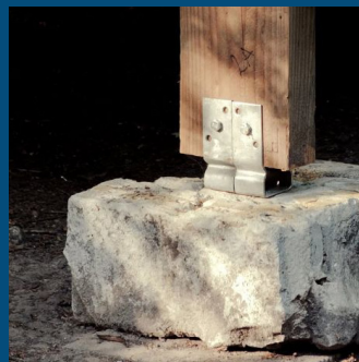
Trækonstruktion på genanvendt betondæk.
