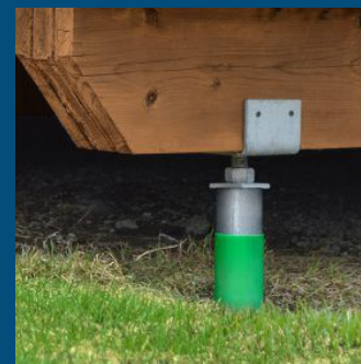
Bebyggelse på skruefundament med u-profil
