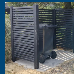
Eksempel på inddækning af renovationsspande.
